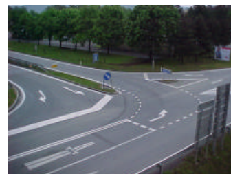
Ausführungsbeispiel einer adaptierten Anschlussstelle
