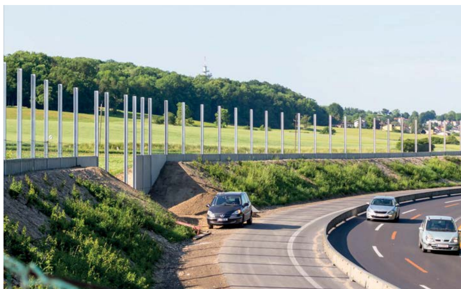
Bild 3: Einschnitt mit oben in Bau befindlicher Lärmschutzwand © Wolfsteiner
