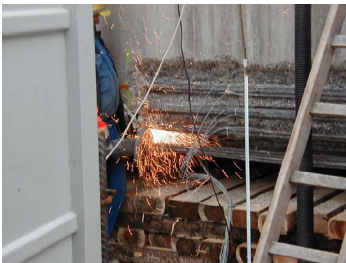
Bild 3. Durchtrennen der Spannkabel
