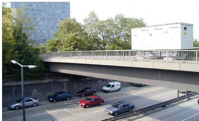
Bild 1. Ansicht der PORR Brücke
