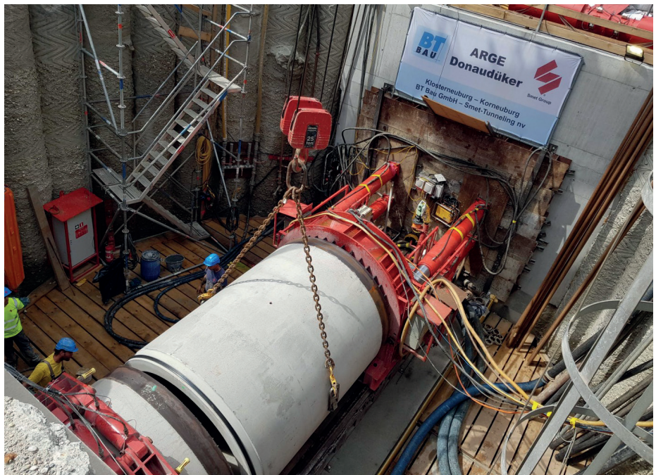
Bild 1: Errichtung des Mikrotunnels DN 2000 für den EVN-Donaudüker Klosterneuburg-Korneuburg (Quelle: Dipl.-Ing. Schneider)
