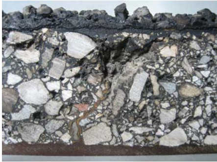
Bild 3: Bohrkernausschnitt einer Überbauungsmaßnahme auf einer Straße mit Asphaltvlies und EO
