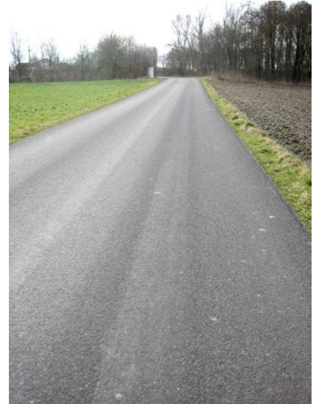
Bild 2: Zustand dieser Gemeindestraße nach Durchführung einer Erhaltungsmaßnahme mit Asphaltvlies und DDK
