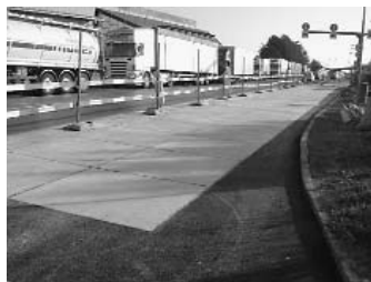
Abbildung 3-1: White Topping – Strecke am Grenzübergang Berg (NÖ)
