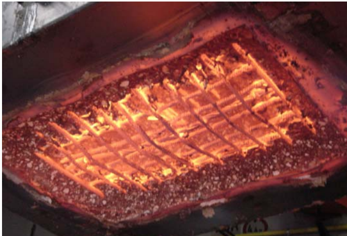
Abb. 1: Versuchskörper nach Brandversuch mit 36 cm tiefem Querschnittsverlust trotz netzförmiger Stahlbewehrung
