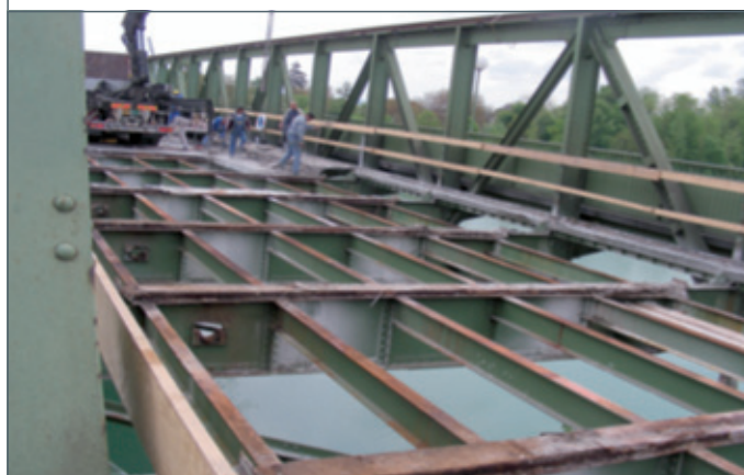
Beispiel: Ennsbrücke bei Komplettsanierung
