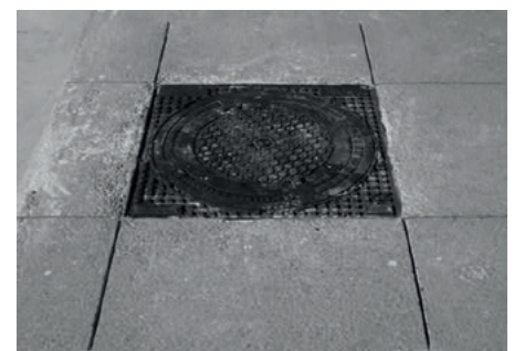
Bild 4: Fugenanordnung bei Einbauten
