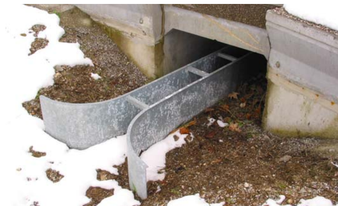
Dauerhafte Amphibienschutzmaßnahme; Eingangsbereich in Tunnel
