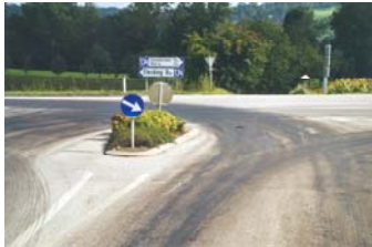
Fahrbahnverunreinigung durch eine vom Baustellenverkehr vertragene Haftbrücke beim Vorspritzen gemäß derzeitigem „Stand der Technik“
