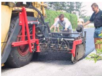
Der Vorspritzfertiger während der Asphaltierungsarbeit
