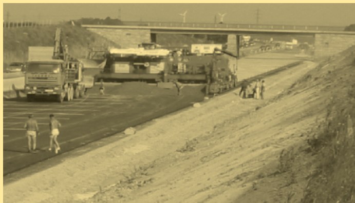
Abbildung 5: Erneuerung in Betonbauweise (Foto Litzka/ISTU)
