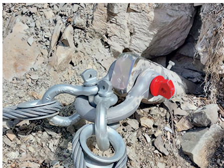
Bild 6: robuster Pfahlkopfanschluss
