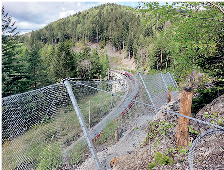
Bild 5: Schutznetz mit Fundierung nach RVS 08.22.02
