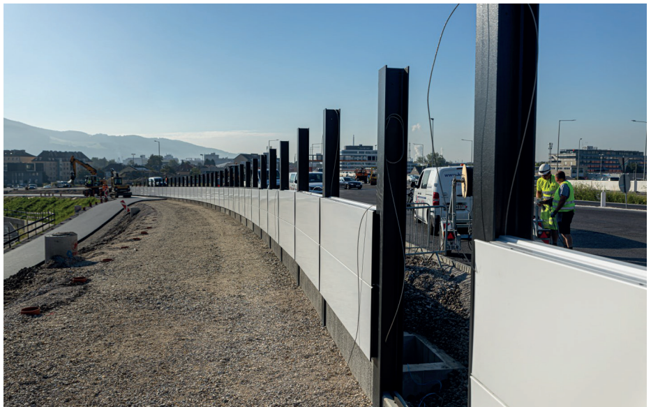
Bild 4: Errichtung von Lärmschutzbauten (Quelle: Wolfsteiner)
