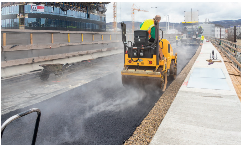
Bild 3: Aufbringung von bituminösen Tragschichten (Quelle: Wolfsteiner)
