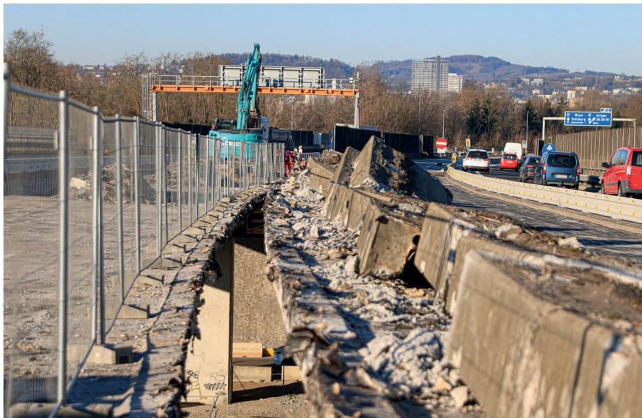
Bild 2: Abtragsarbeiten auf einer Autobahnbrücke (Quelle: Wolfsteiner)
