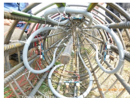
1: Foto eines Energiepfahls mit Absorberrohr
