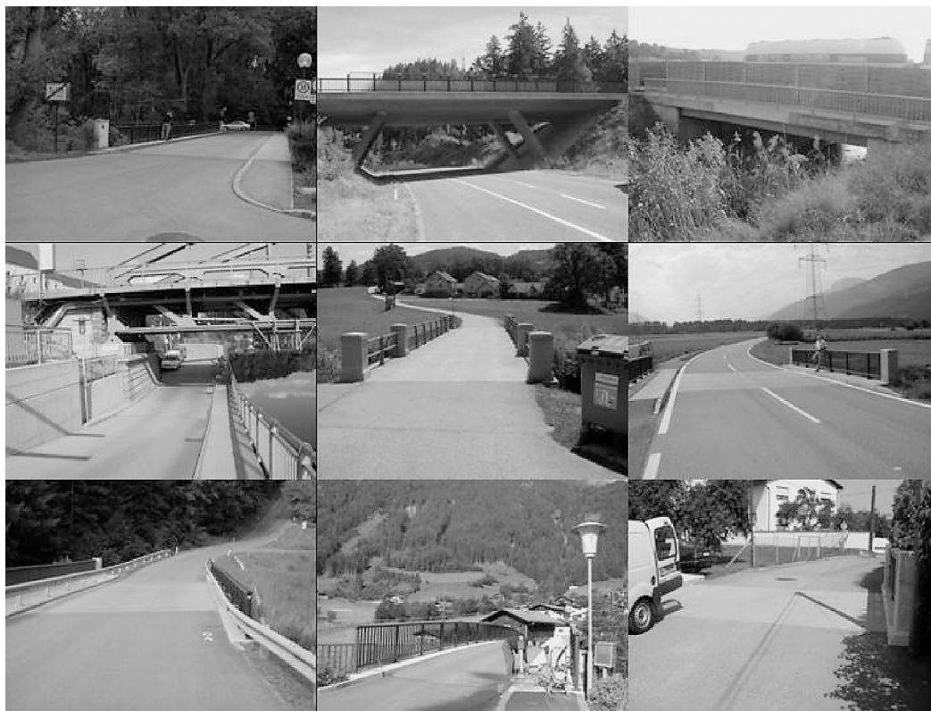
Abbildung 2: Die untersuchten Brücken aus HL-Beton ohne Abdichtung
