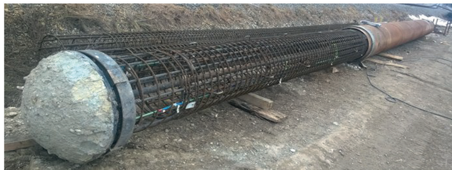
Bild 8: Foto eines oberen Pfahlteiles mit Doppelwandrohr
