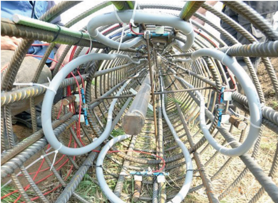
Bild 5: Fotos von einer Energiepfahl-Herstellung, im rechten Bild sind die Absorberrohre zu erkennen
