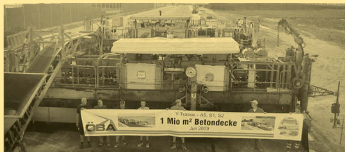
Abbildung 6: 1 Mio m² Betondecke
