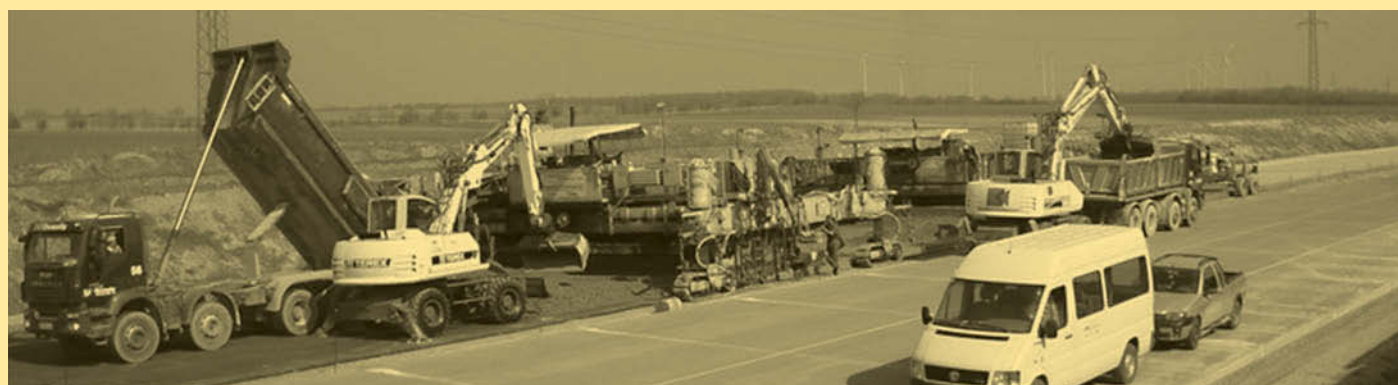
Abbildung 3: Bau der Betondecke
