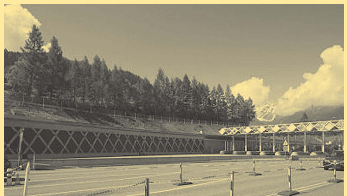
Bild 1: Neue Ankerwände im Bereich der A 13, Mautstelle Schönberg ©ASFINAG
