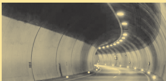
Abbildung 4: 80er Jahre – Beleuchtung Langener Tunnel
