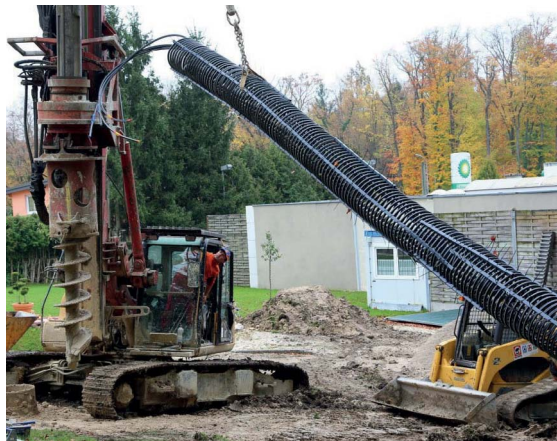
Bild 5: Belegung von Sonderformen – Spiralkollektoren © VÖBU
