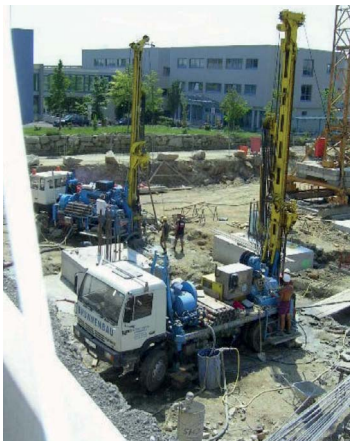
Bild 4: Tiefensondenbohrung © VÖBU
