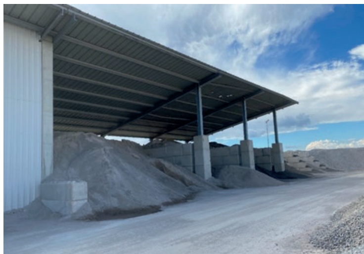
Bild 4: Überdachung der Gesteinskörnung in einer Asphaltmischanlage
