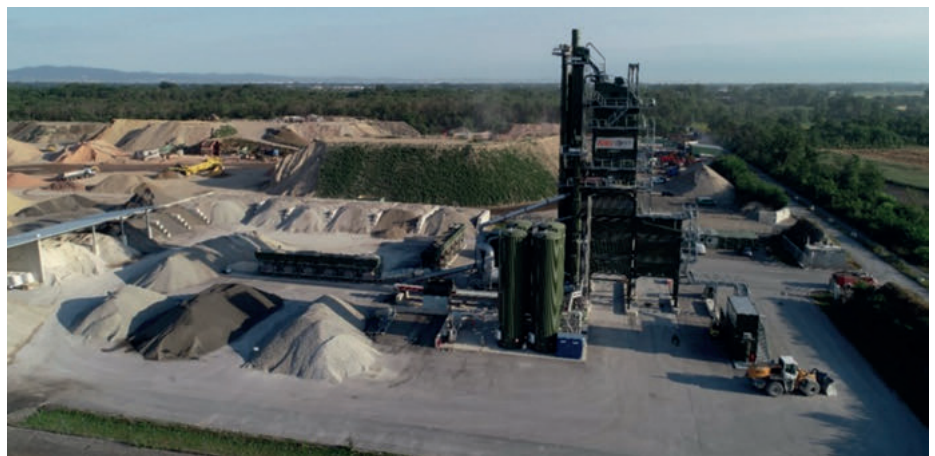
Bild 3: Aufnahme einer Asphaltmischanlage
