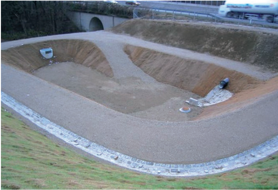
Bild 2: Baulich fertiggestelltes Bodenfilterbecken vor der Begrünung
