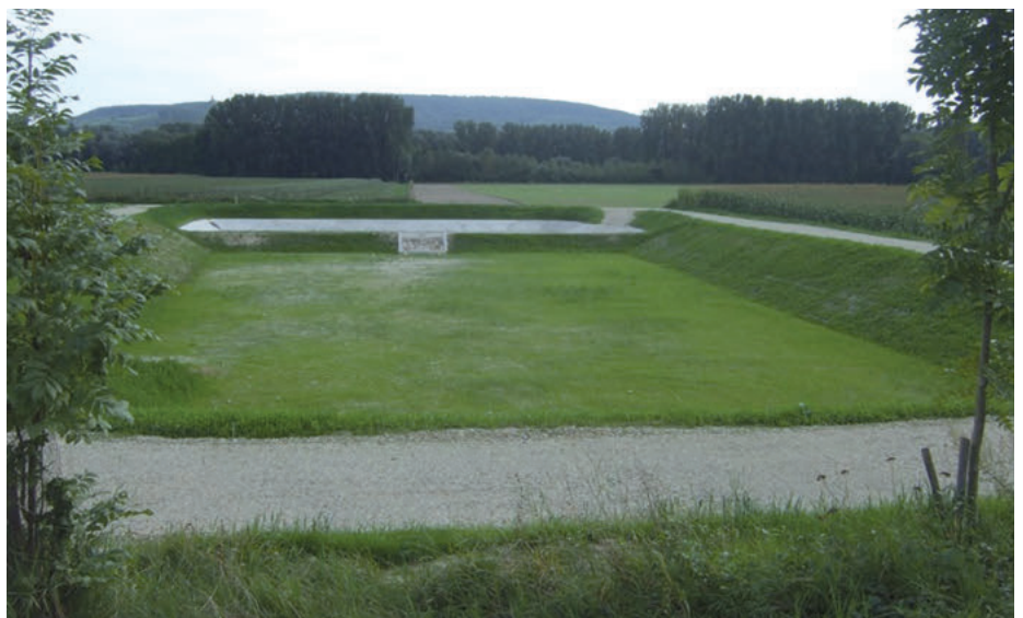
Bild 3: In Betrieb befindliches begrüntes Bodenfilterbecken
