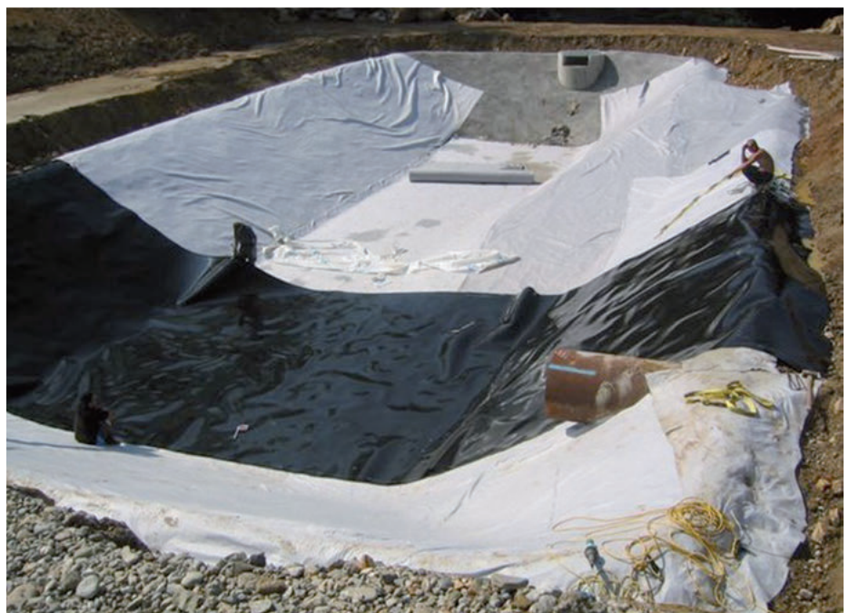
Bild 1: Im Bau befindliches Absetzbecken, Herstellung der Abdichtung
