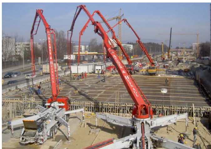
A7 Mühlkreis Autobahn, Tunnel Bindermichl – Herstellung in Deckelbauweise: 25 cm Faserbeton zur Sicherstellung der Brandbeständigkeit, zwei Lagen Normalbeton à 50 cm („Weiße Wannen-Beton“)
