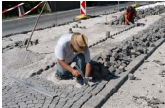
Pflastern von Granitkleinstein 8/10 im Segmentbogenverband in ungebundener Bauweise
