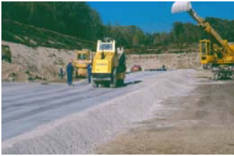
Einbau von REA-Material in einer Deponie-Basisabdichtung
