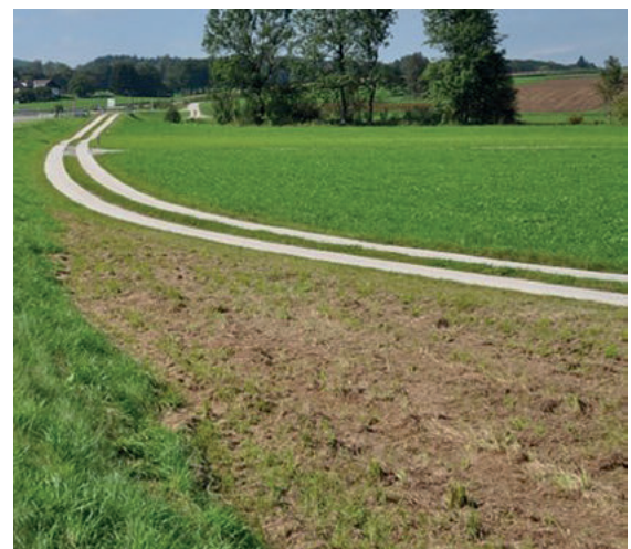
Bild 4: Spurweg mit zwei betonierte Spuren © Haslehner
