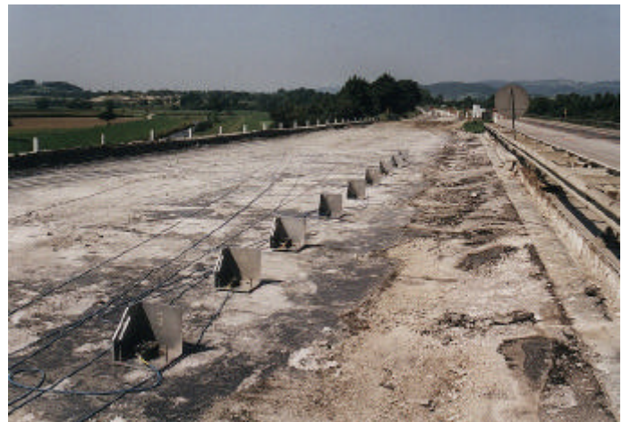
Schwingungsuntersuchung mittels Messsystem BRIMOS an der Melkflussbrücke Winden
