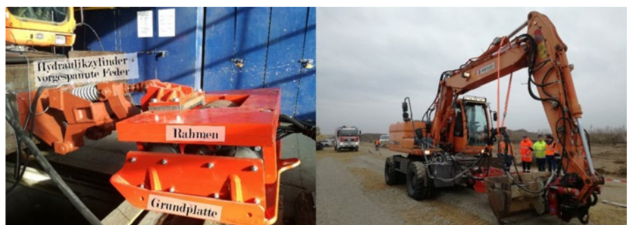
1: Befestigung des Plattenverdichters & Messfahrt am Versuchsgelände
