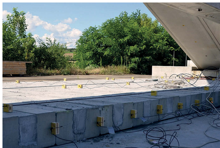
Bild 4: Prototyp der Fahrbahnübergangskonstruktion während der Belastungsversuche ohne bituminösen Fahrbahnaufbau.
