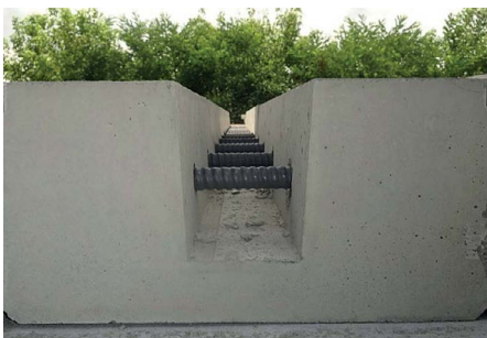
Bild 3: Betonelement der Fahrbahnübergangskonstruktion mit eingebauten GFK-Zuggliedern
