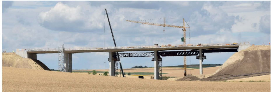
Bild 5: Pilotprojekt „Satzengrabenbrücke“ an der A 5 Nordautobahn
