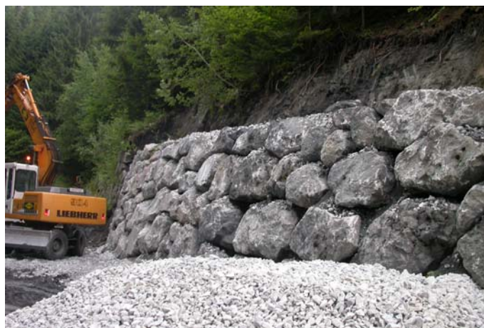
Steinschichtung als Böschungssicherung
