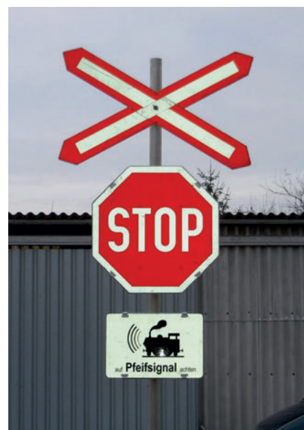
Bild 1: Eisenbahnkreuzung mit nicht technischer Sicherung mittels Andreaskreuz, Verkehrszeichen „Halt“ und Zusatztafel „auf Pfeifsignale achten“
