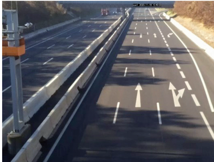
Bild 2: Aufnahme einer Kamera auf der Geh- und Radwegbrücke über der A2, Süd Autobahn, AB-Km 183.173, in Feldkirchen bei Graz
