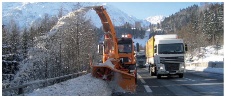
Bild 1: Schneefräse auf einer Landesstraße B, Räumung kommt vor dem Streuen
