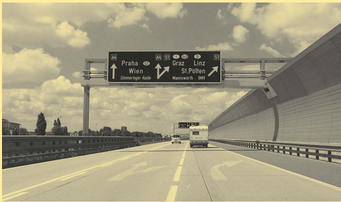
Bild 4: Überkopfwegweiser A 4 (Quelle: ASFINAG)
