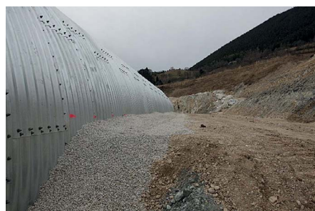
Bild 2: Ordnungsgemäße Hinterfüllung
