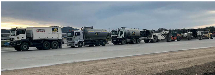
Bild 1: Baugeräte zur Herstellung einer Stabilisierung in der Reihenfolge des Herstellungsprozesses
