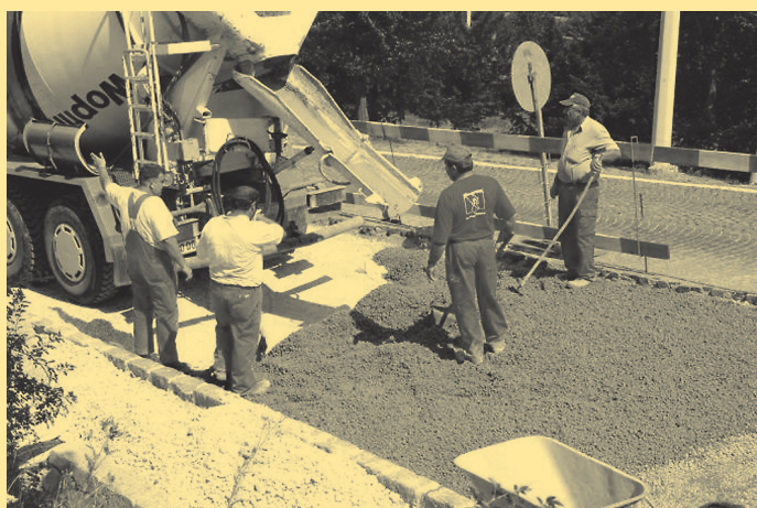
Abbildung 1: Einbauen von Pflasterdrainbeton
