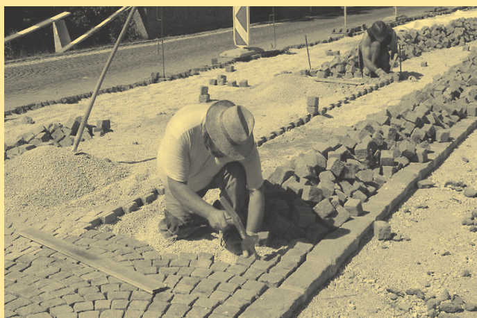
Abbildung 2: Pflastern von gebrauchtem Granitkleinstein im Segmentbogenverband in ungebundener Bauweise
