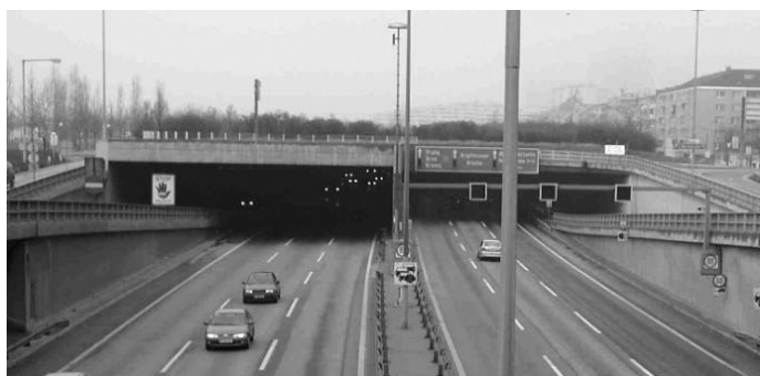
Abbildung A1: Ansicht des Tunnelportals. Die Messungen wurden in der linken Tunnelröhre (Fahrtrichtung Südost) durchgeführt.
