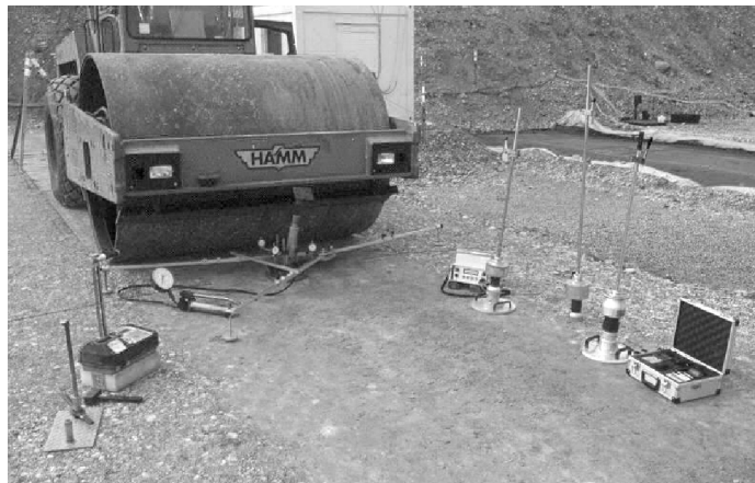
Abbildung 5: Beim Passieren einer Oszillationswalze am bindigen Versuchsfeld in unterschiedlichen Tiefen gemessene Verformungen
