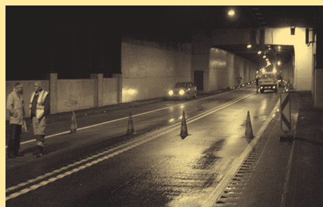
Bild 5: Die Leistung umfasst neben dem eigentlichen „Tunnel“ auch die Portalbauwerke sowie Flügel- und Stützmauern im unmittelbaren Bereich der Portalfußpunkte
