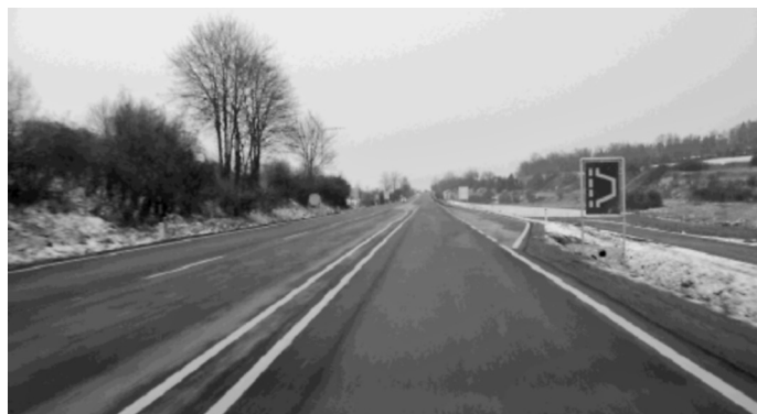
Abbildung 2: B303 Waldviertler Straße mit 2+1-Querschnitt (vor einer Pannenbucht im einstreifigen Richtungsabschnitt)
