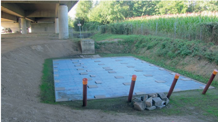
Bild 2: Technischer Filter beengt unter einer Brücke und ohne ausreichende natürliche Bewässerungsmöglichkeit bzw. Bewetterung
