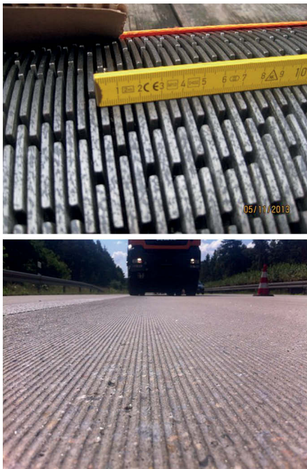
Bild 2: Grindingwelle und fertige Oberfläche
