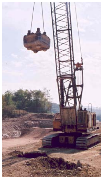
Abb. 1: Dynamische Intensivverdichtung mit Raupenkran und Fallgewicht
