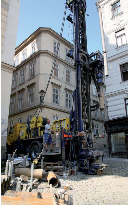
Bild 1: Probebohrung für die U2-Verlängerung
