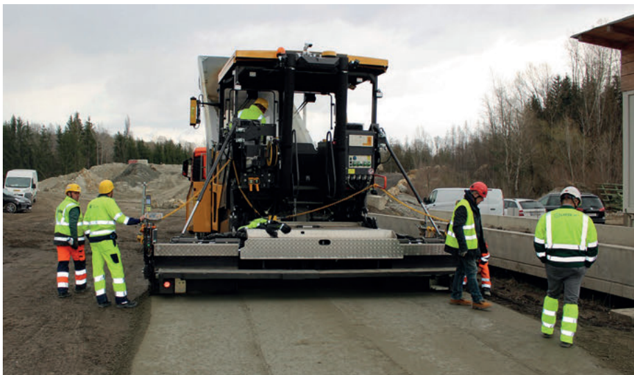
Bild 1: Betoneinbau mit Fertiger mit Hochleistungsverdichtungsbohle
