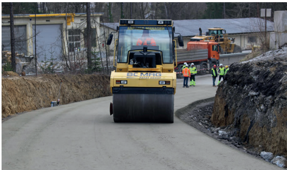
Bild 2: Verdichtung der Walzbetonteststrecke
