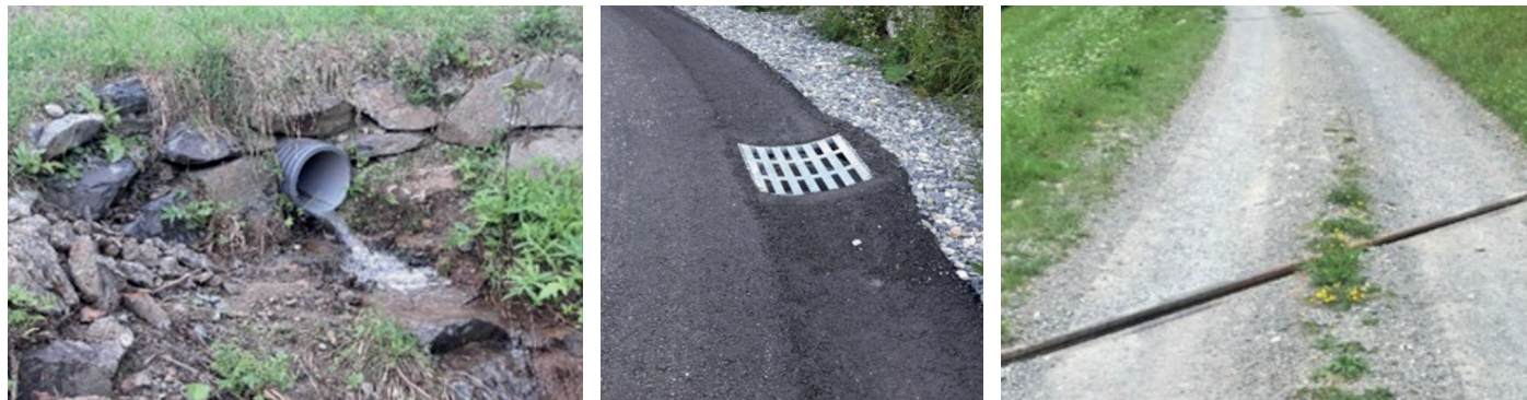
Bild 3: links: Auslaufabsicherung mit Steinschichtung; Mitte: Asphaltmulde, rechts: Querrinne bei ungebundener Befestigung
