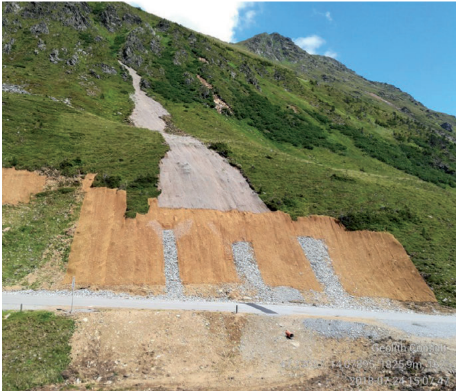
Bild 2: Rutschungssanierung Sölkpass, Passhöhe (etwa 1.826 m ü. A.) 2018 (Quelle: Schmidt C.)
