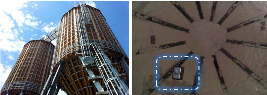
**Abbildung 23 Baugleiche Salzsilos (links) mit jeweils einem Datalogger(rechts) zur Aufzeichnung von Temperatur und Luftfeuchtigkeit**
